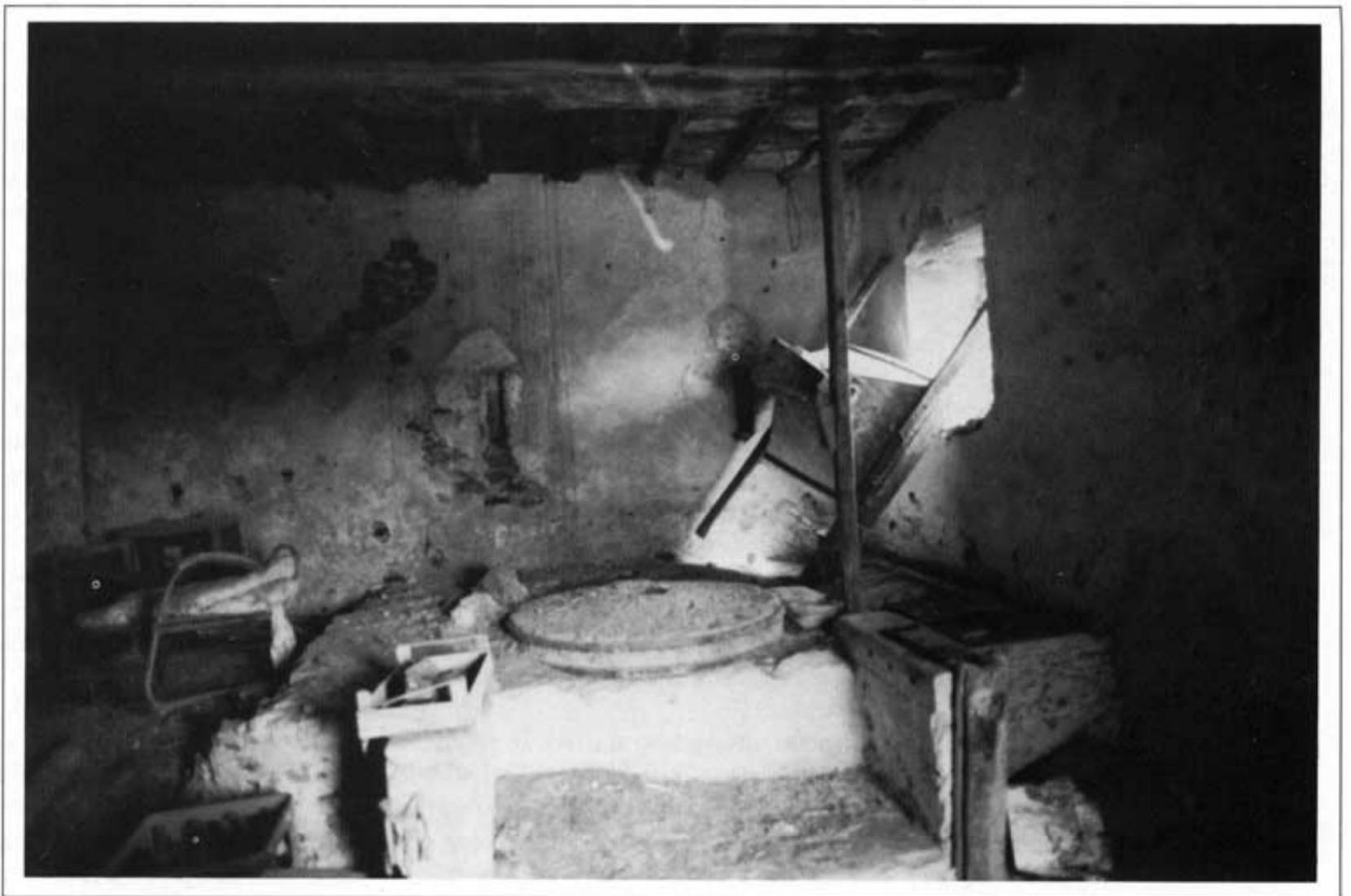
SOLAI: solaio di calpestio travi e travicelli coperti con tavoloni di legno cadente; solaio di copertura travi e travicelli coperti con mezzane, cadente
